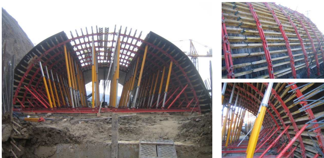
Figuras 44 a 46 – Cimbres e cofragem das abóbadas
