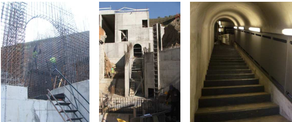
Figuras 22 a 24 – Túneis de acesso
