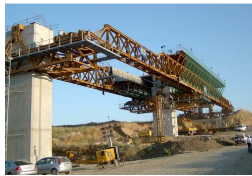
Figura 2. Viaduto sobre o rio Genil na LAV Córdoba-Málaga, constituído por vãos isostáticos de 48,0 m e com um comprimento total de 1390 m
