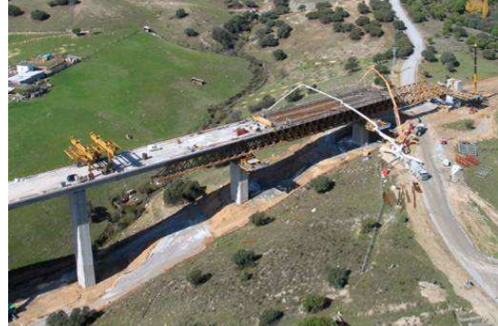
Figura 4. Viaduto de Salobral, LAV Madrid – Valladolid [4]
