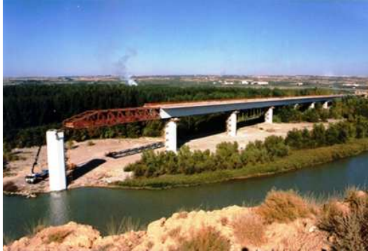
Figura 3. Viaduto sobre o rio Cinca, LAV Madrid – Barcelona [3]
