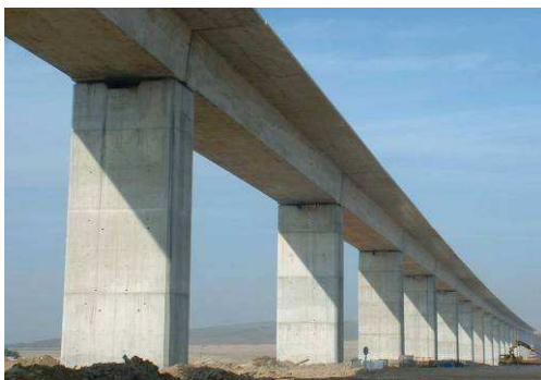
Figura 2. Viaduto sobre o rio Genil na LAV Córdoba-Málaga, constituído por vãos isostáticos de 48,0 m e com um comprimento total de 1390 m
